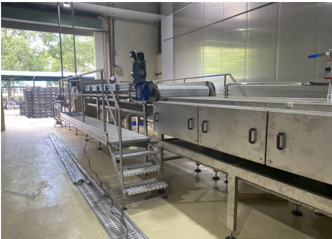
Thiết bị chần trái cây / rau quả tại một nhà máy nước trái cây ở Việt Nam, giai đoạn lắp đặt. Ảnh tư liệu Kim Nguyễn.
