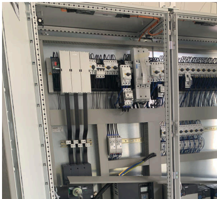
Đầu nối tủ điện điều khiển trong giai đoạn lắp đặt.
