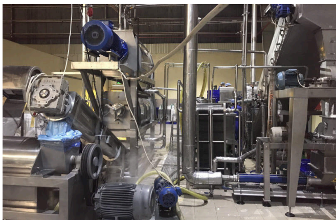
Nhà máy nước trái cây cô đặc – cụm ép và nghiền của dây chuyền chế tạo tại Ý, giai đoạn lắp đặt. Ảnh tư liệu Kim Nguyễn.
